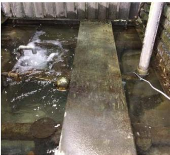
スライム障害とは、冷却水中で繁殖した微生物がスライムを形成し、冷却塔や熱交換器に付着する現象です。スライムは冷却効率を低下させるだけでなく、腐食障害を促進する原因にもなります。また、スライムに含まれるレジオネラ属菌が増殖すると、レジオネラ肺炎などの疾病を引き起こすリスクが高まります。
