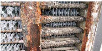
腐食障害とは、冷却水中の酸素や微生物が金属部分を腐食させる現象です。これにより、金属の劣化が進行し、設備や配管の破損による水漏れのリスクが高まります。
