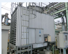
福岡県／工場長様 クーリングタワー 80冷却トン1基、その他3基
